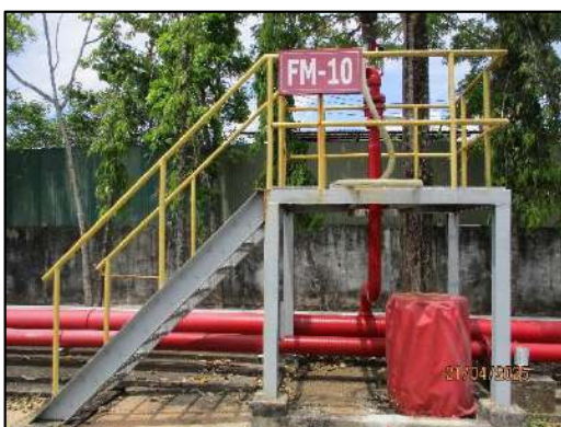
ภาพถ่ายที่ 2.2-24 ระบบฉีดน้ำดับเพลิงแบบโฟม
